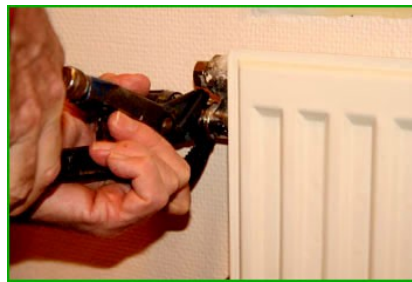
Bild 2 Här använder du rörtången eller polygripen, använd inte våld.
