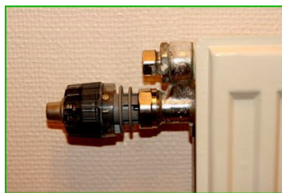
Bild 5 Så är det dags att sätta tillbaks termostathuvudet, tänk på att du får siffrorna vända utåt.
