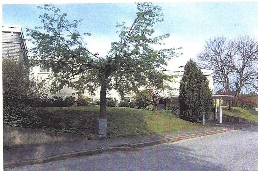
Bild 7. Utanför E-husen har marken planats av vid sidan av stödmuren.
