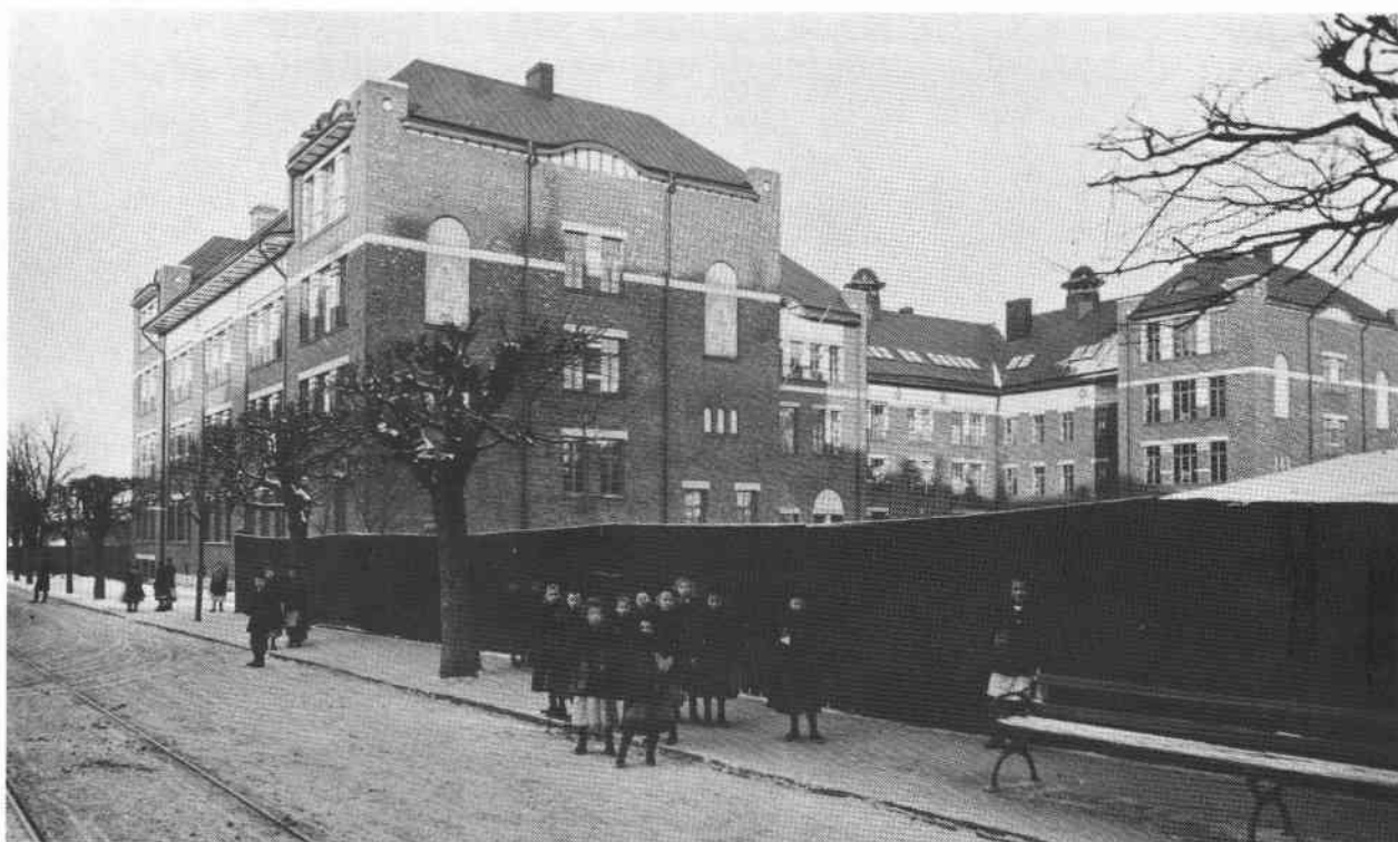
Matteus folkskola i kv Skalmejblåsaren, sedd från Norrtullsgatan. Foto 1902.
