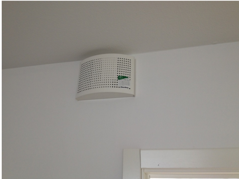
Figur 6. Tilluftsdon, FläktWoods STQA. Placeras i lägenhetens rum.
