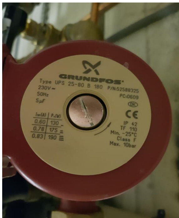
Figur 9. Cirkulationspump till VV, från år 2006.
