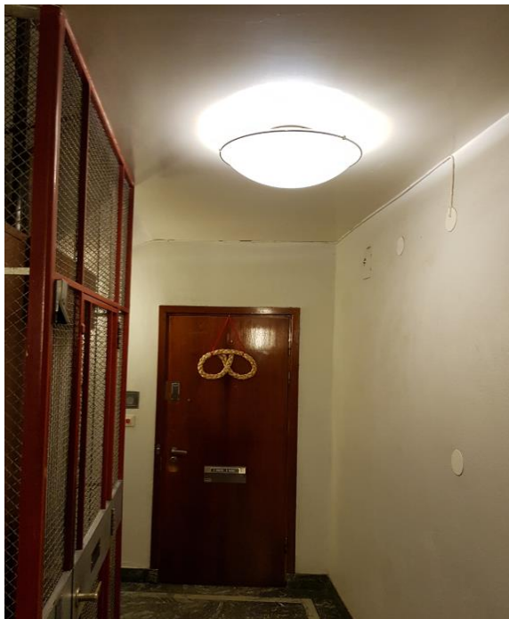
Figur 12. Belysning i trapphus med närvarostyrning.
