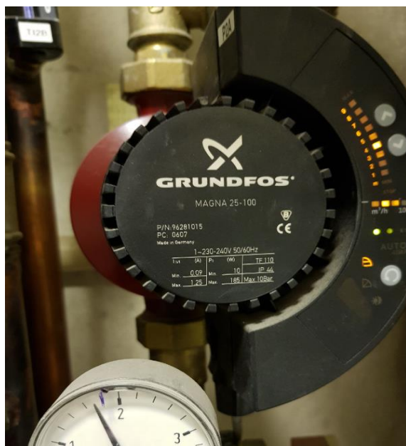
Figur 8. Cirkulationspump på VS-krets, från år 2006.
