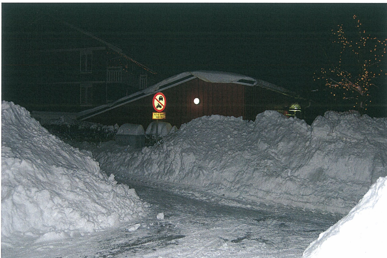
Här ligger snön 3-metershög vid gången till soprummet.
