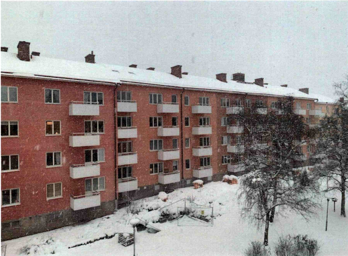
Föreningens nya fasader Vapengatan 3 - 11
