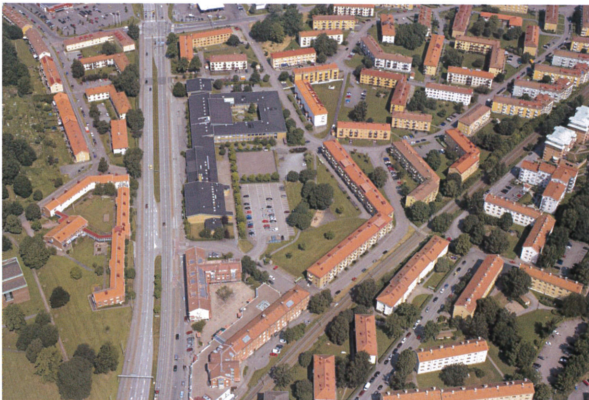
Området sett söderifrån. Skolbyggnaden är nu riven
