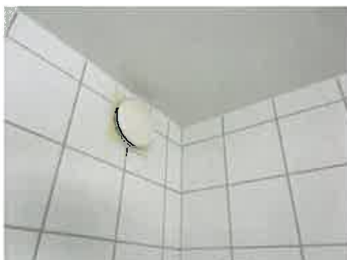
Trapphus ventileras via ventil i yttervägg
